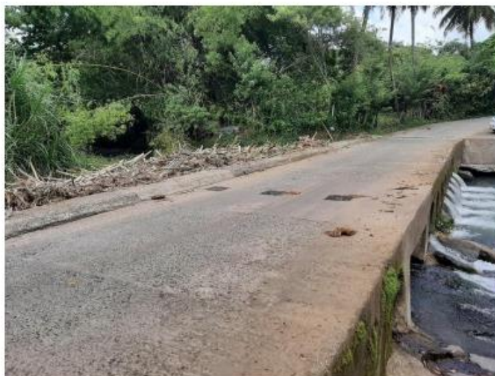
Figure 1 : Accumulation de bambous en amont du gué de la RD 27.
