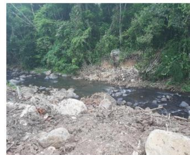
Figure 3 : Rétablissement du bon écoulement de la rivière après intervention.
