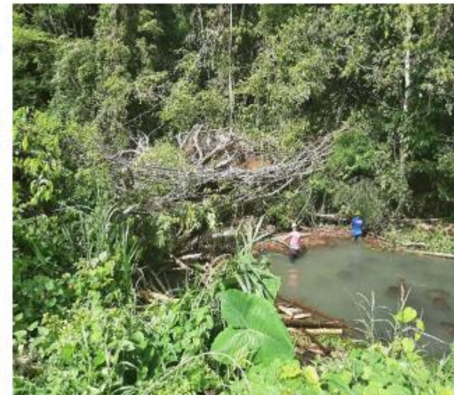
Figure 2 : Intervention de découpage puis d'évacuation
