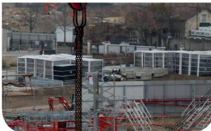
**3** Mise en place des blocs nidaplast® RA sur 2 couches en joints croisés
