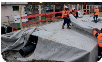
**8** Remblaiement sur la structure 10 cm minimum de grave 20/40 pour constituer la couche de ventilation
