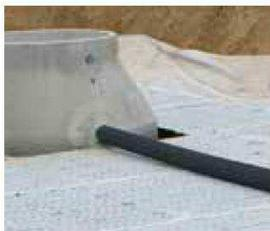
Chaque regard ventilé en amont et aval du bassin doit être connecté à un drain routier perforé DN100 classe SN8, type **nidaevent**, posé sur la dernière couche de blocs.
