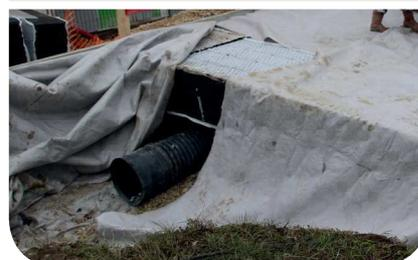
**7** Enveloppement des blocs avec le géotextile non-tissé aiguilleté de 300g/m<sup>2</sup>
