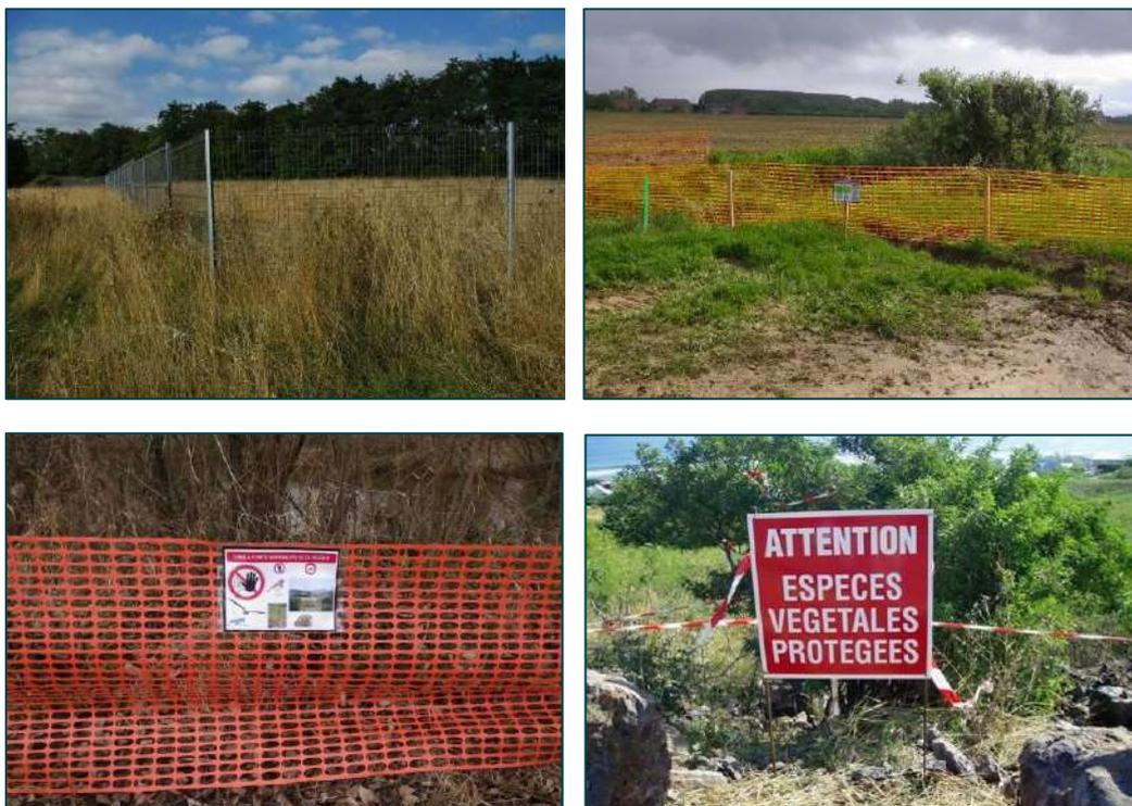
Figure 31 : Différents types de balisages de zones sensibles en bordure des emprises à mettre en place avant les travaux. © Biotope
