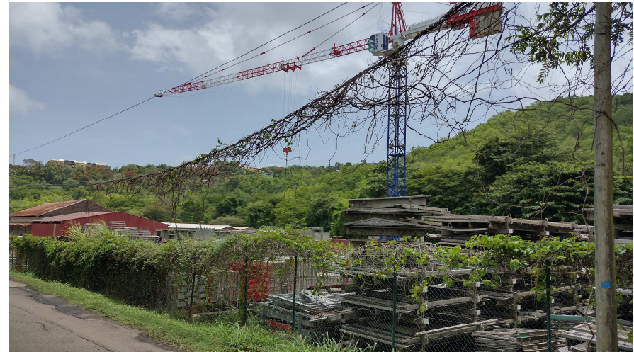
Vue n°4 : zone de stockage de matériaux de construction aux droits de la rue Aubin Edmond
