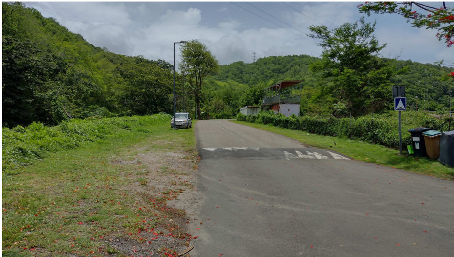
Vue 11 : rue Jules Ferry avant ouvrage de franchissement
