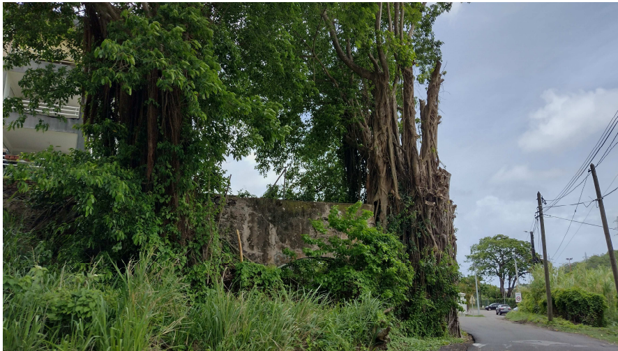
Vue n°5 : mur remarquable sur rue Aubin Edmond
