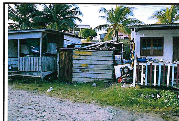
Abri à démolir
