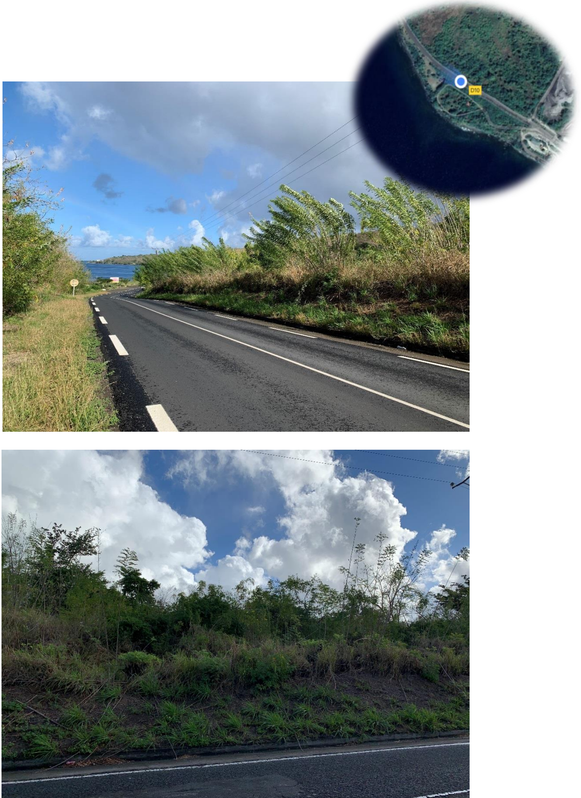
Figure 4 : Déblais et habitats dégradés du site du projet visibles depuis la D10 (Source : SUEZ CONSULTING, Février 2021)
