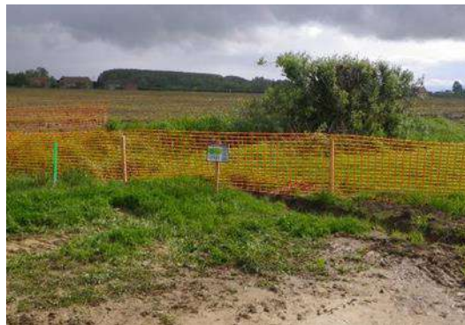
Exemple de balisage des zones sensibles en bordure des emprises à mettre en place avant les travaux. © Biotope
