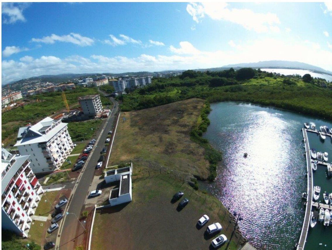
Figure 6 : Photographie par drone du site (source : CACEM, 2017)
