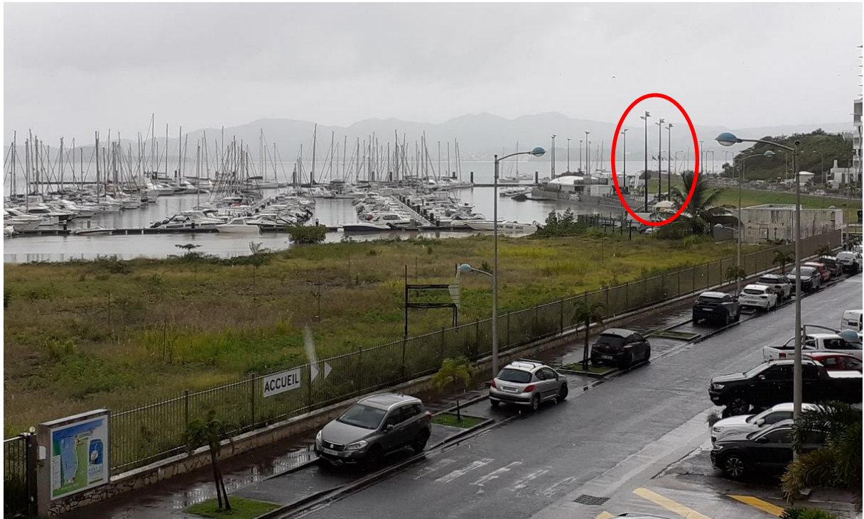
Figure 111 : Vue sur la rue Moi Laminaire et le quai B à droite en arrière-plan
