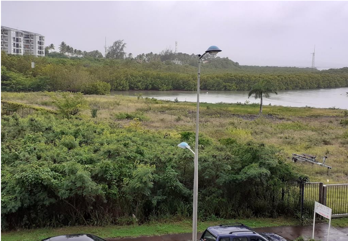
Figure 112 : Candélabre avec 2 faisceaux orientés vers le réseau viaire et le trottoir
