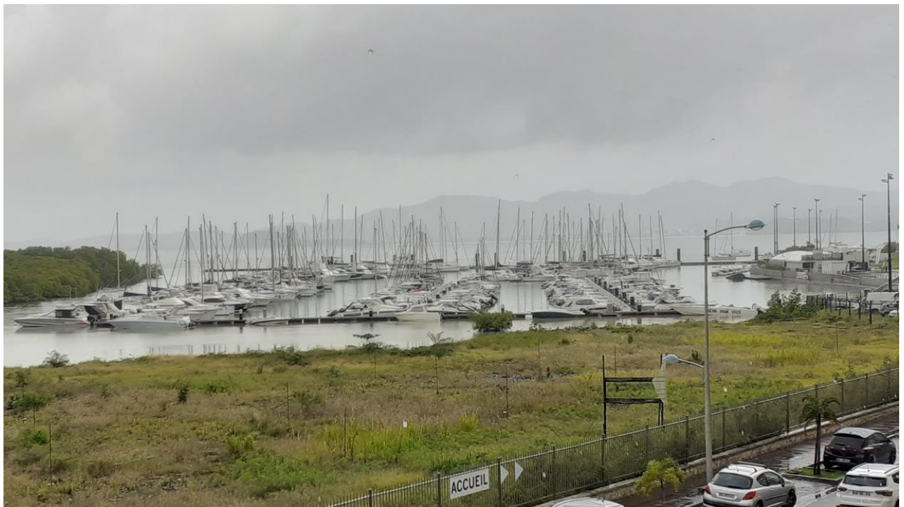
Figure 110 : Absence de luminaires au droit des pannes du port de plaisance d'Etang Z'abricots (Source : SUEZ CONSULTING, Juillet 2022)
