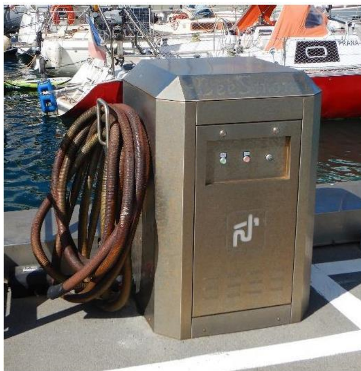
Figure 12 : Poste de relevages des eaux usées (Source : Plan pluri annuel d'aménagement du port de plaisance d'Etang Z'Abricots (rapport axe 1))
