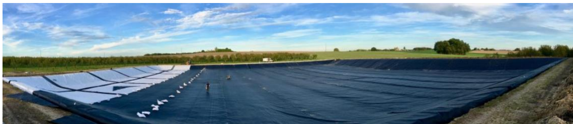
Figure 36 : Exemple de pose de géomembrane (Source : Kipopluié)
