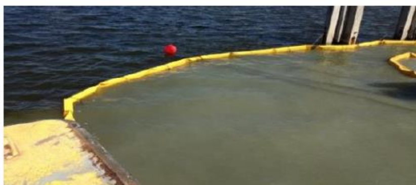
Figure 91 : exemple de rideau géotextile anti-MES
