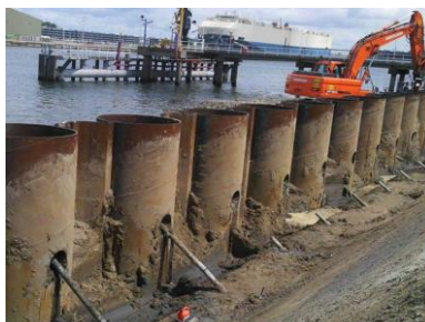
Figure 16 : Exemple d'écran avec tirants inclinés autoforeurs (Source : Ginger Géode)
