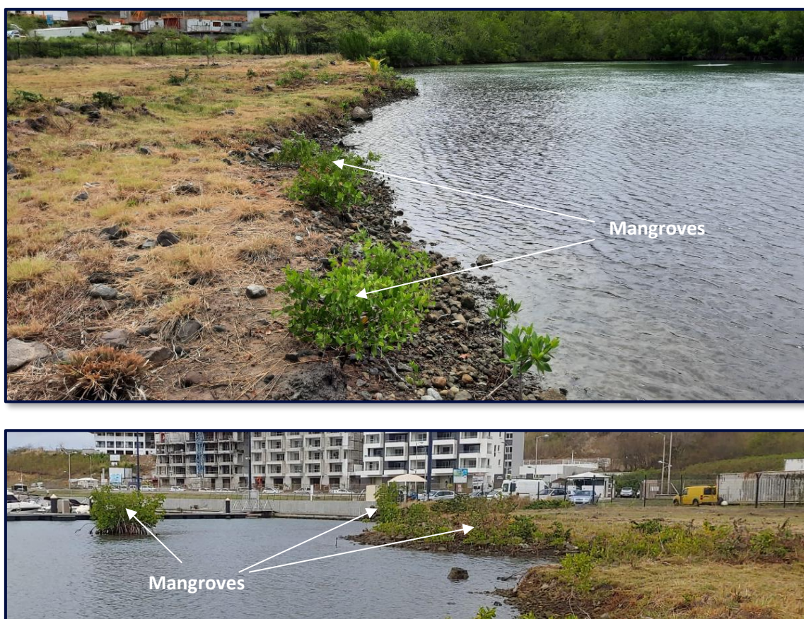
Figure 4 : développement de nouvelles pousses de jeunes mangroves le long du terreplein (source : photos 2021, Suez Consulting)
