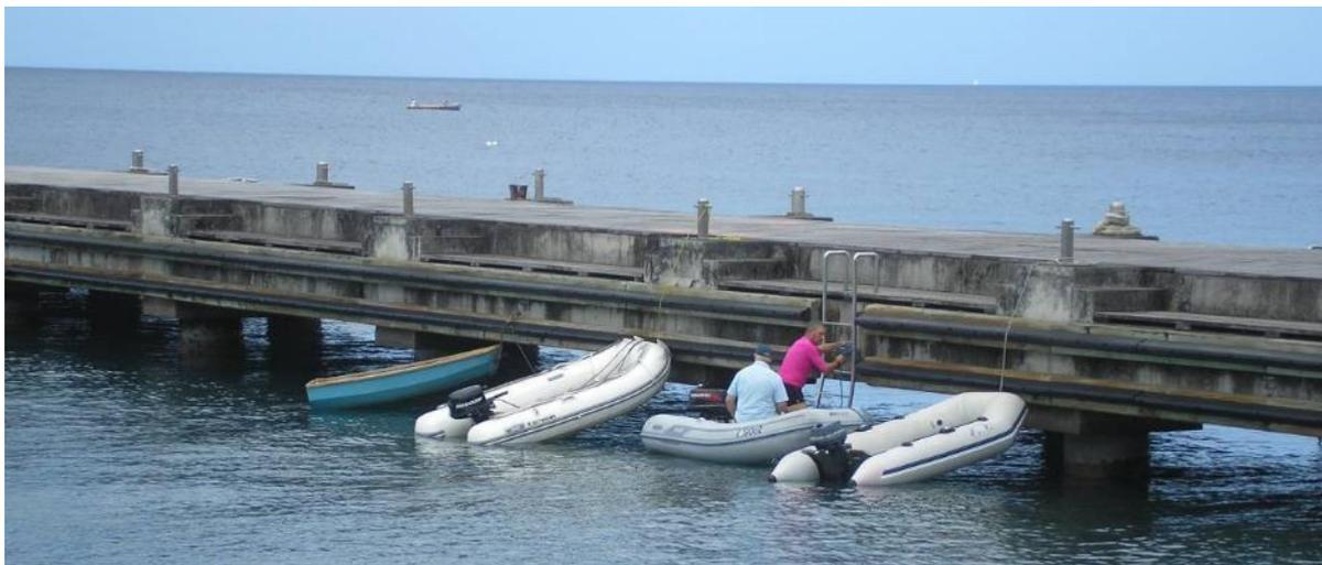
Figure 14 : Amarrage inapproprié des annexes sur les appontements à passagers
