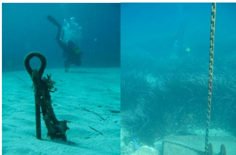
Figure 12 : Photographies d'un corps-mort ensouillé dans le sable (à gauche) et d'un corps-mort déposé dans une cuvette de sable entre les posidonies (à droite)
