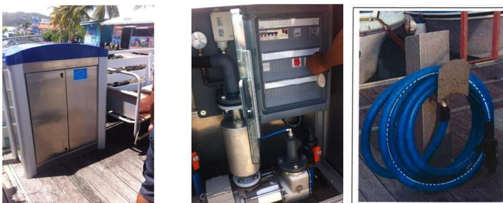
Figure 23 : Exemple de Poste de pompage des eaux noires (port du Marin)
