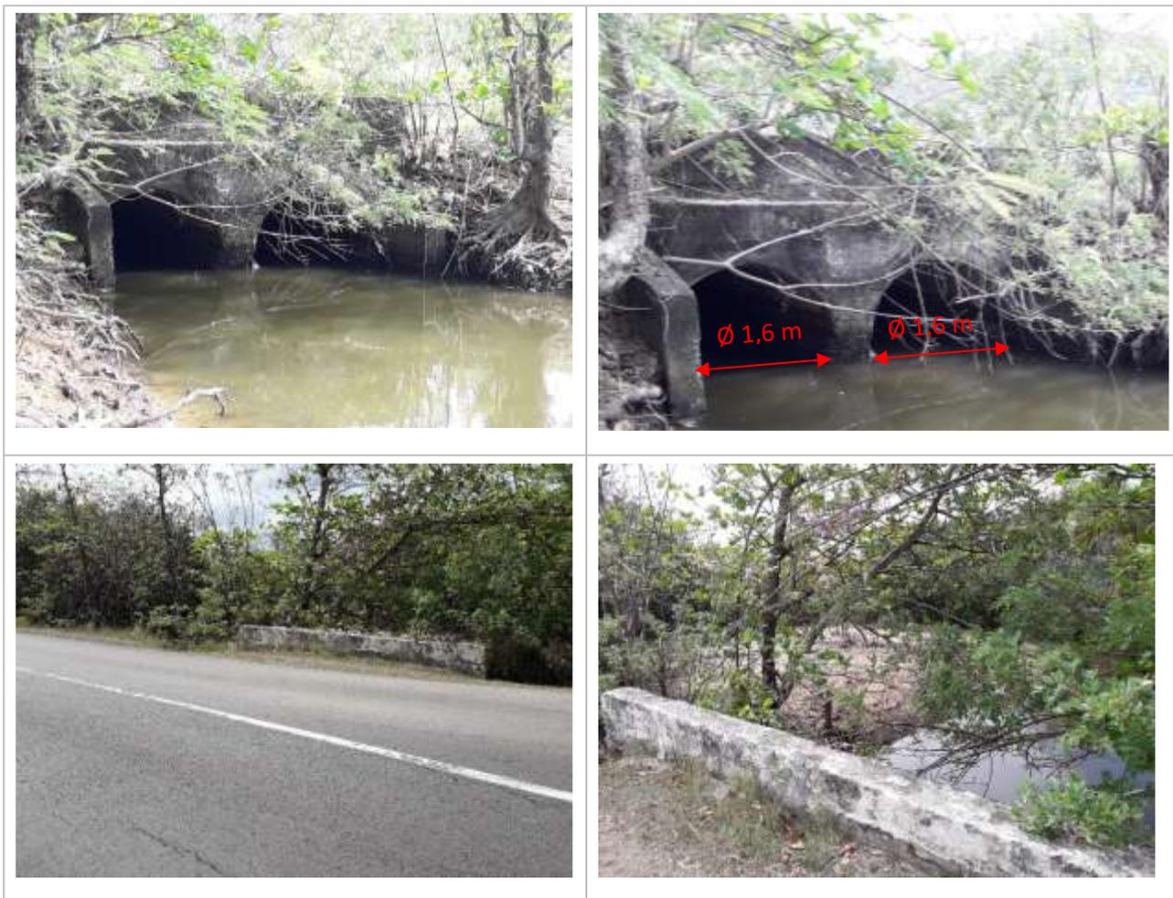
Figure 1 : Photographies de l'ouvrage exutoire du bassin versant de la ravine la Brèche
