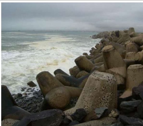
Figure 5 : Exemple de durcissement de la cote par tétrapodes et enrochements
