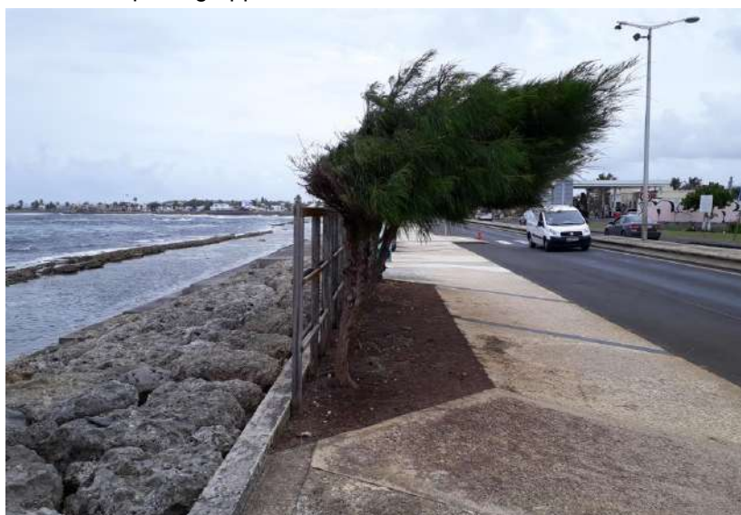
Figure 16 : Exemple de fosse de plantation dans trottoir en arrière d'un enrochement – Le Moule 971
