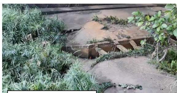
Ouvrage sous la D7
