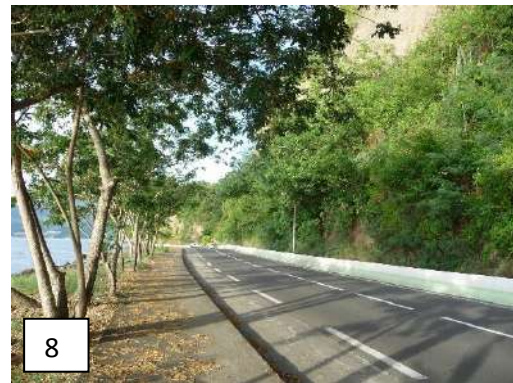
Figure 109 : Vue de la fin de la zone d'intervention depuis le sud vers le Nord
