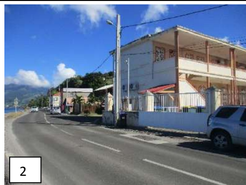
2 Figure 103 : Vue de la RN 2 et de l'école du Carbet depuis le point de départ de la réhabilitation
