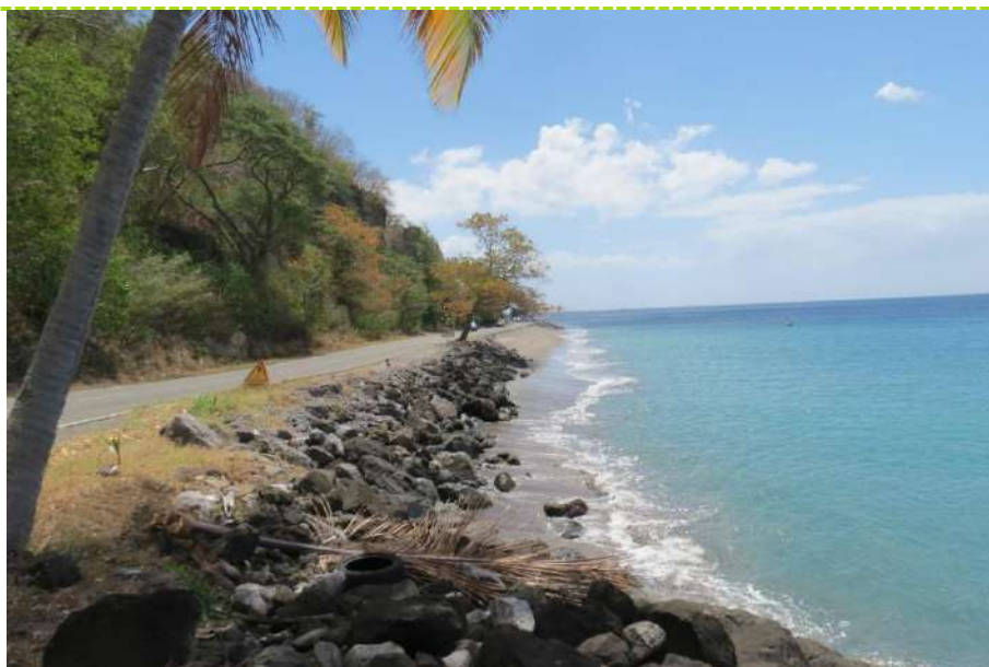
Figure 75 : Photo de la zone 1 caractérisée par son talus à forte pente (source : SUEZ Consulting 01/03/2019)
