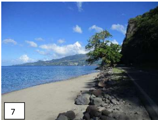
Figure 108 : Vue des enrochements existants depuis le sud vers le Nord
