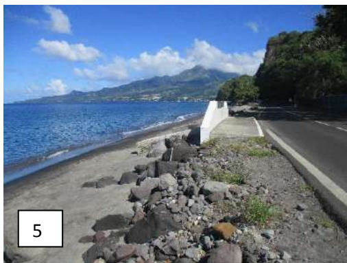
5 Figure 106 : Vue depuis l'amont de l'ouvrage hydraulique de traversée vers le nord
