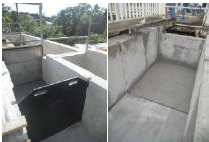
Figure 16 : Exemple de batardeau amovible (Source : SUEZ CONSULTING)
