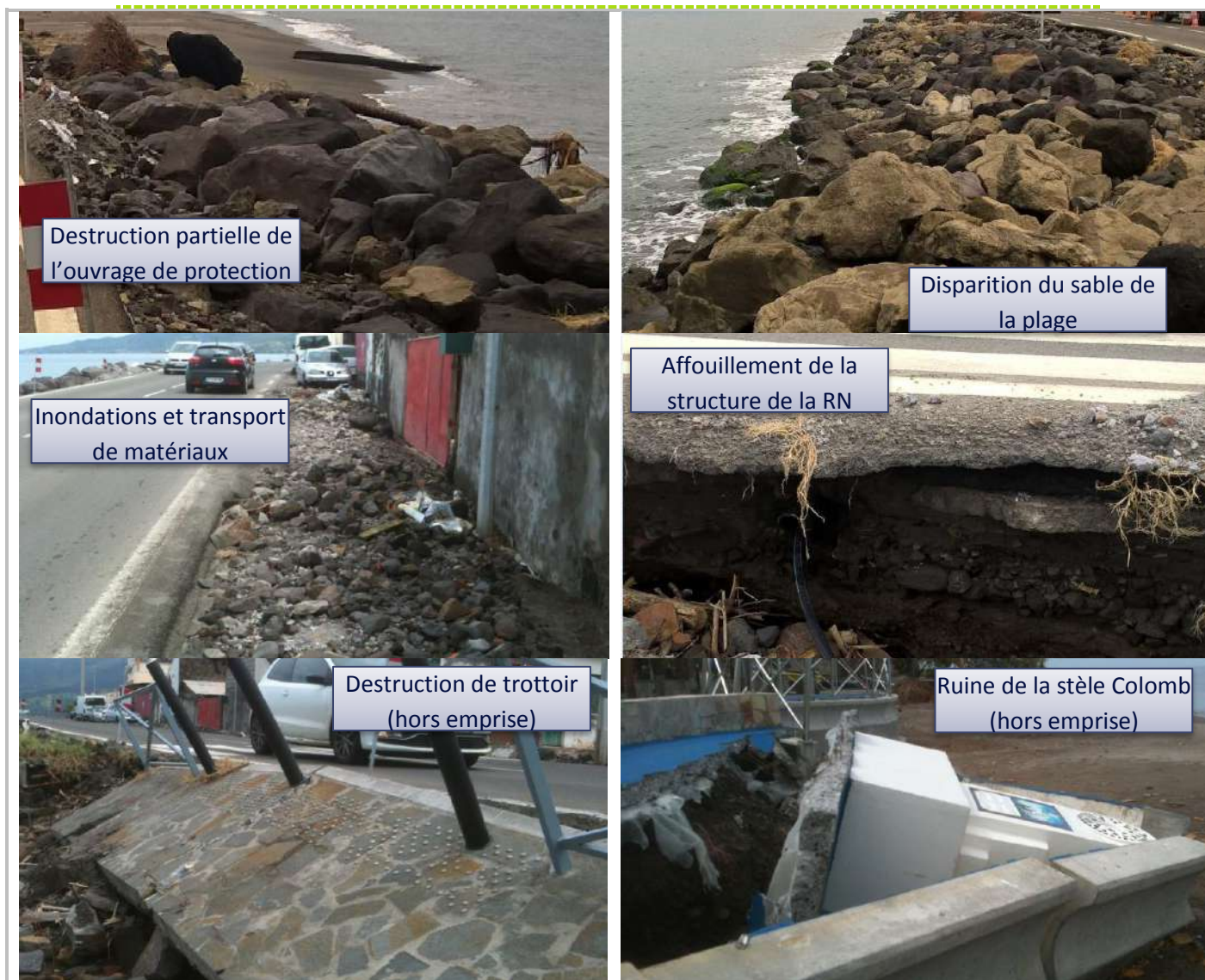
Figure 121 : Photographies des dommages engendrés par les évènements cycloniques de 2017
