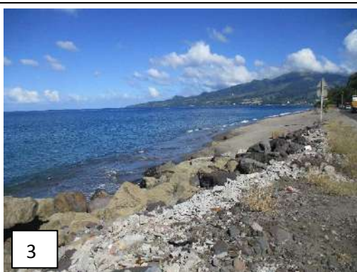
3 Figure 104 : Vue depuis le Sud vers le Nord
