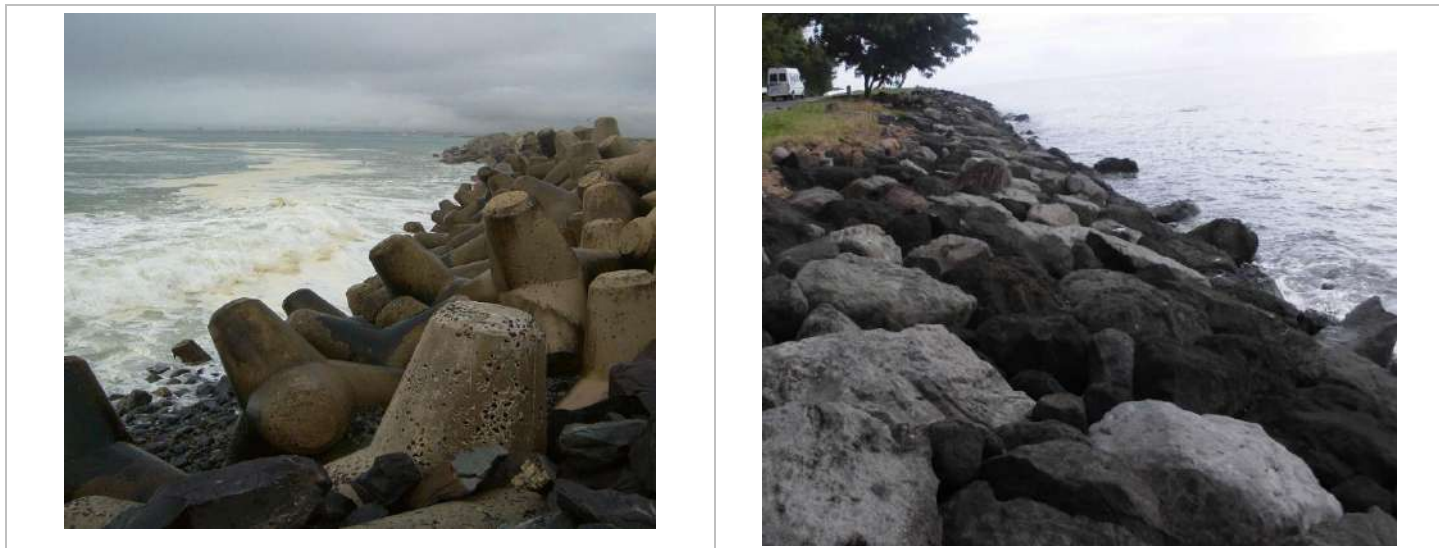
Figure 5 : Exemple de durcissement de la cote par tétrapodes et enrochements
