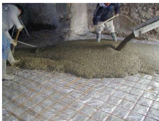
Figure 127 : exemple de polyane sous une dalle béton
