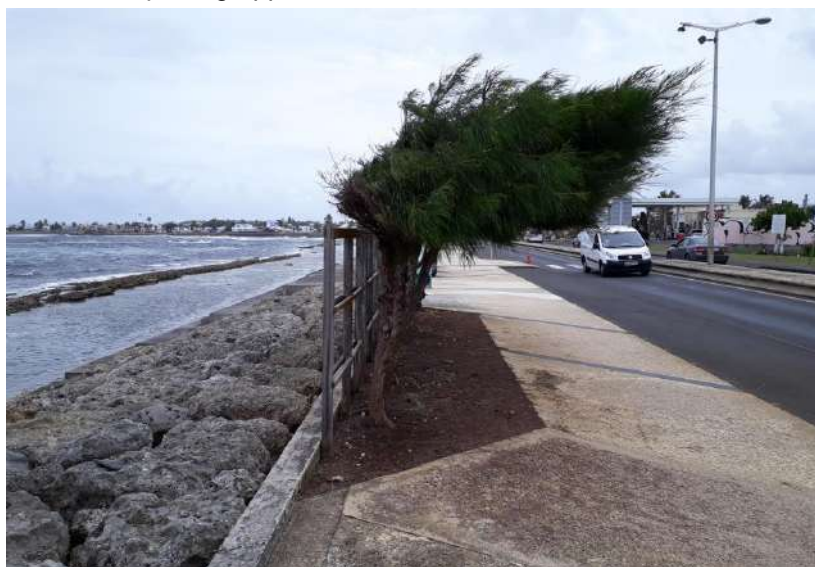
Figure 22 : Exemple de fosse de plantation dans trottoir en arrière d'un enrochement – Le Moule 971
