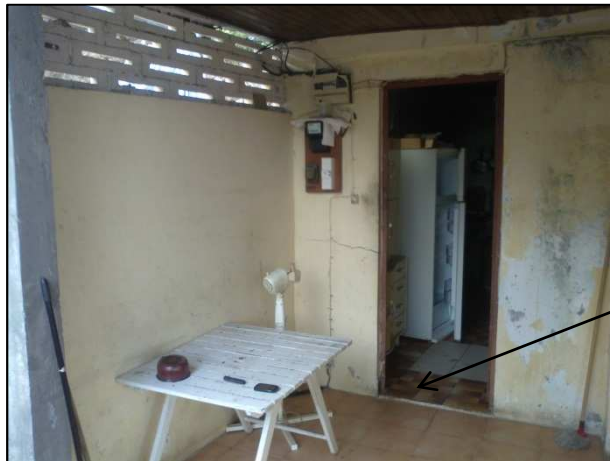
Fissures sur le mur à l'entrée de la cuisine
