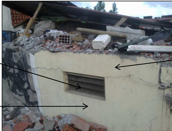
Fissure à la jonction mur maçonné en brique / poutre béton armé
