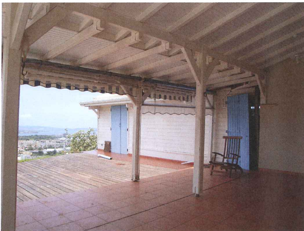
Un aperçu de la terrasse associée à l'habitation principale avec au fond à droite la partie avec soubassement maçonnerie et bardage bois et le deck contigu.
