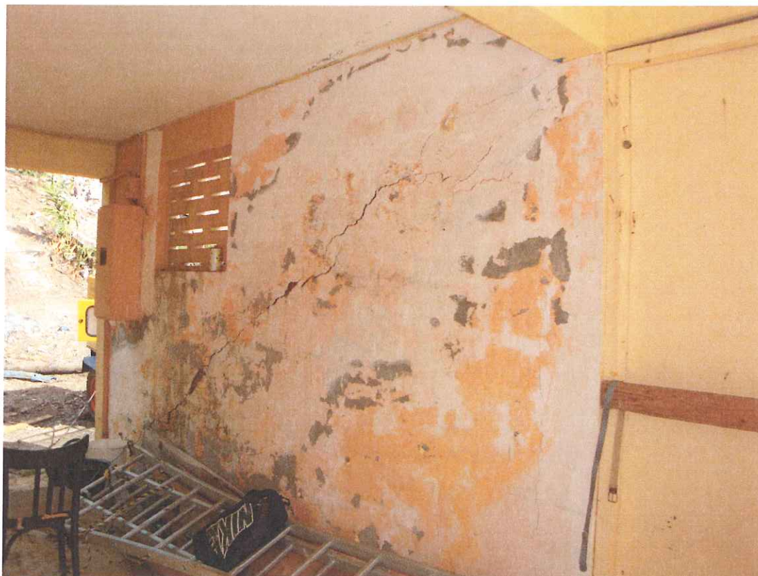
Fissure en diagonale dans le panneau de façade contigu à l'escalier extérieur
