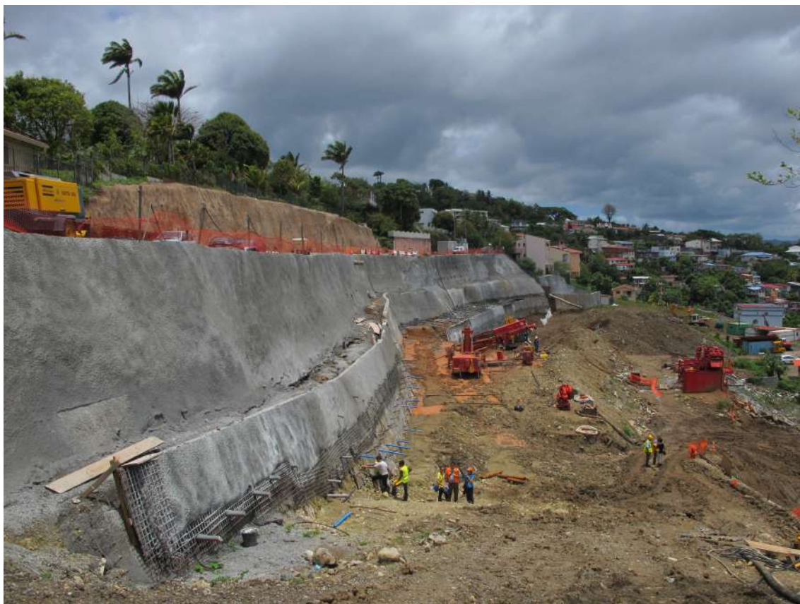
Figure 6 : Le chantier fin avril 2013. De haut en bas et de gauche à droite : le mur amont de la RD 48, la RD 48, le mur aval « Conseil général », le mur « Ville » en cours de construction et les terrassements dans le corps du glissement.
