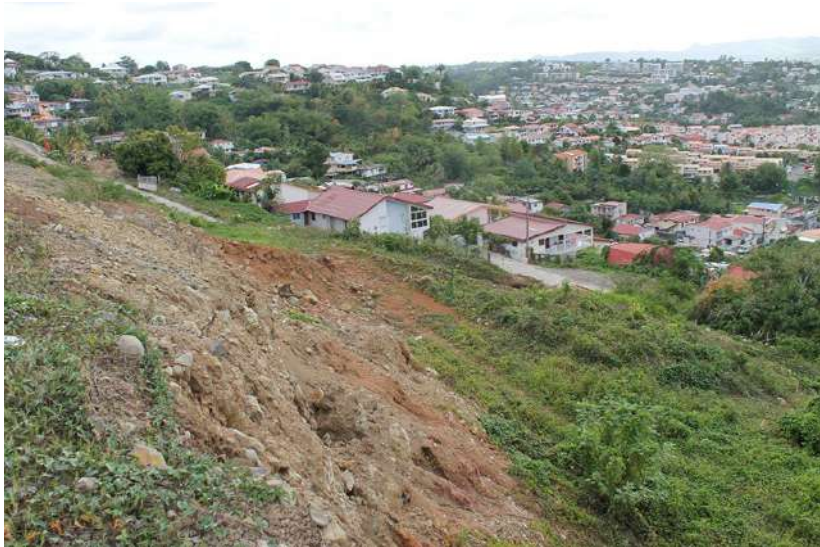
Figure 2 : bourrelet de pied à mi-chemin entre les profils Abis et B
