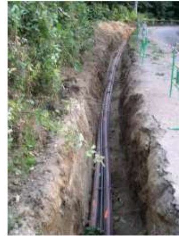
Exemple de pose en fourreaux PEHD pleine terre
