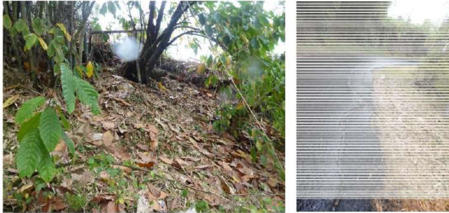
ILLUSTRATION 9 : NICHE D'ARRACHEMENT DANS LES COLLUVIONS EN CONTRE BAS DE LA ROUTE (PHOTO DE GAUCHE) ENDOMMAGEANT LA CHAUSSEE EN TETE (PHOTO DE DROITE).
