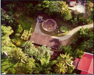
Assainissement Collectif Station d'épuration Morne-Rouge - Chazeau
