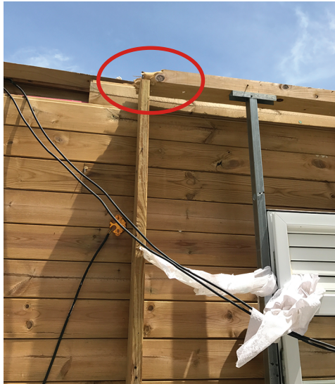
Figure 1 : Section probablement insuffisante (CAUE)
