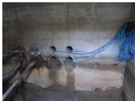
Figure 2 : Vue intérieure d'une chambre-plage (Orange Marine)
