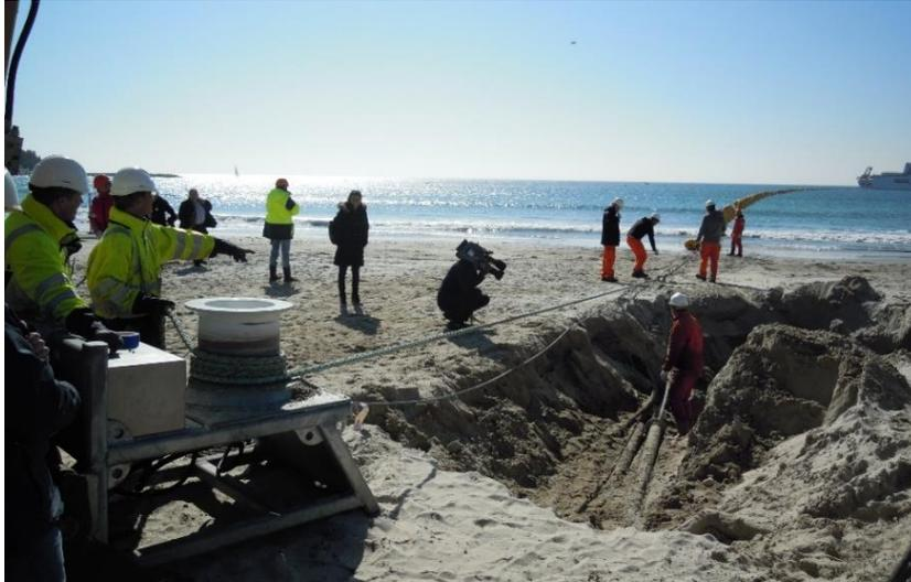
Figure 5 : Opération de tirage du câble avec un cabestan hydraulique
