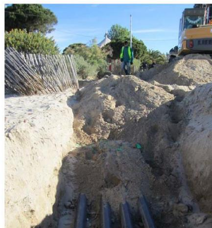
*Figure 3 : Illustration de fourreaux d'accueil en haut de plage, dégagés à l'occasion des travaux préparatoires à la réception d'un câble en 2014 (Orange Marine)*
