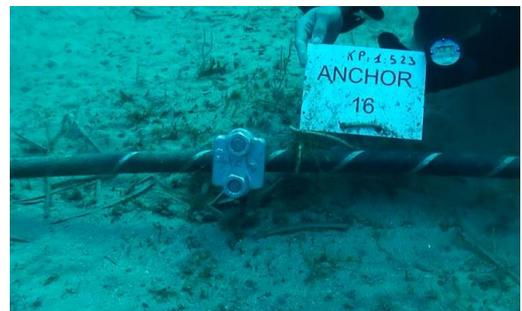
Figure 8 : Système de fixation du câble à l'ancre retenu pour le projet (Orange Marine)
