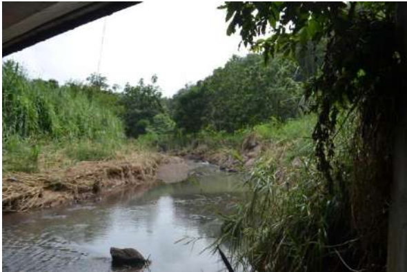
Station 1 : Pont Madeleine (vue vers l'amont)
