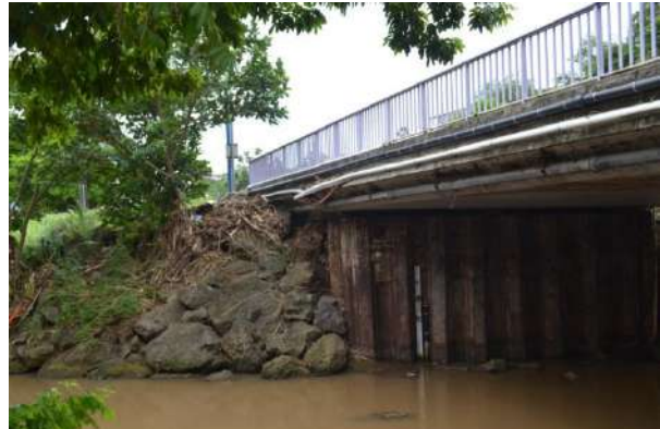
Station 2 : Pont Pomponne (Face aval)
