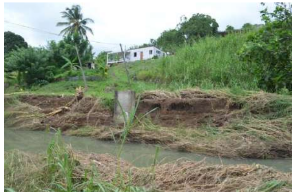
Station 4 : Passerelle Guénot (Vue depuis la rive gauche)
