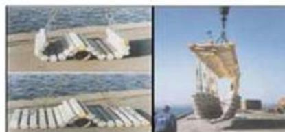
Figure 9. Matelas en béton<sup>14</sup>
