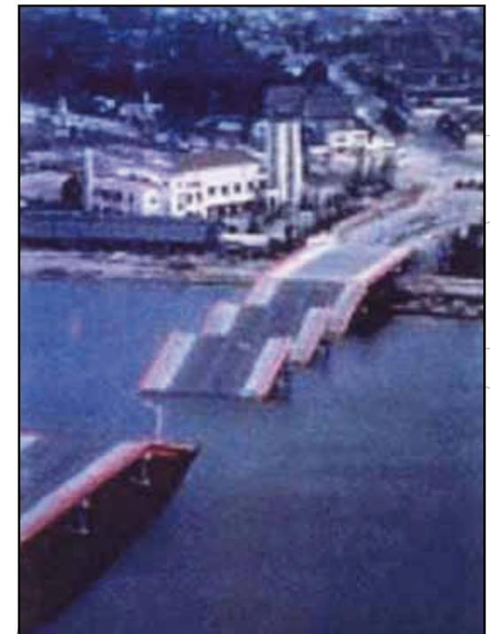
Ruine d'un ouvrage d'art pour non prise en compte de l'aléa local : liquéfaction du sol d'implantation des piles du Showa Bridge, 1964. (NISEE-USA)
