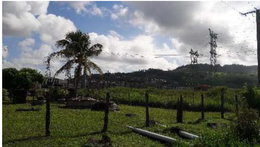
Photographie 7 : Vue du site depuis la parcelle 391 à l'Ouest
