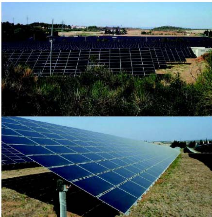
Figure 51. Centrale photovoltaïque au sol vue de face et de profil
