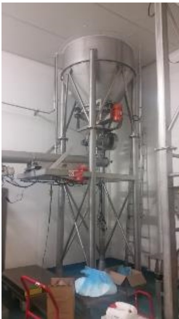
Silo de sucre
