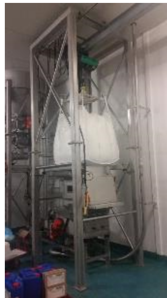
Support métallique pour le support des big bags
