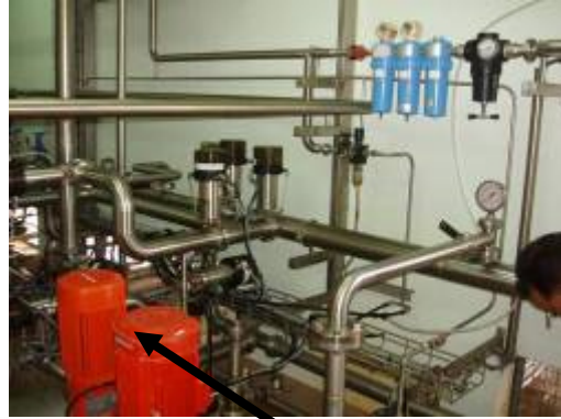
Pompe de reprise pour le nettoyage de la canalisation d'amenée de l'eau du forage
