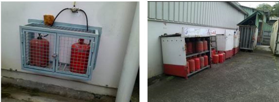
Figure 32 : Stockage des bouteilles de gaz
