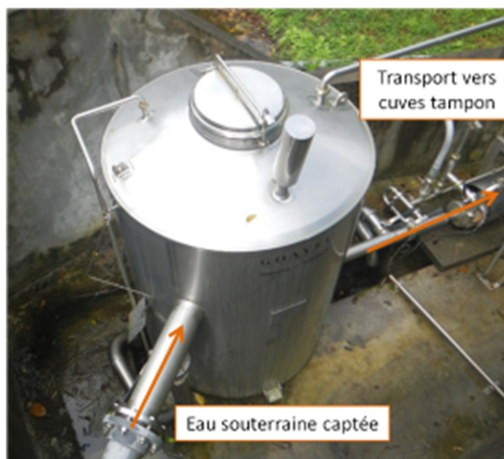
Figure 7 : Photographies des canalisations de la source de Mont Béni
