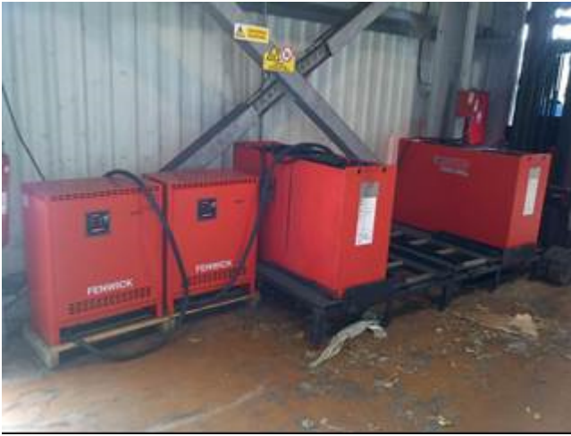
Zone de chargement des batteries des élévateurs
