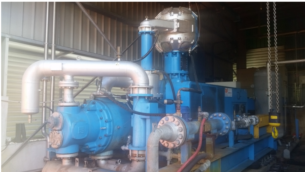
Figure 25 : Compresseur 40 bar
