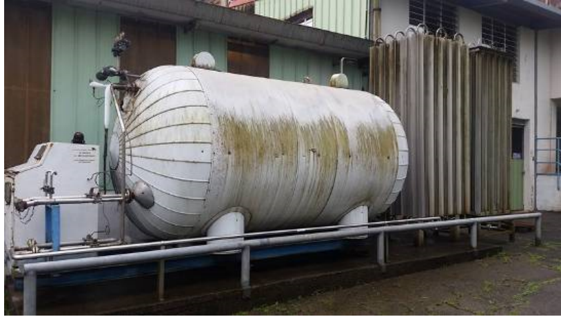
Figure 27 : Cuve de CO2
