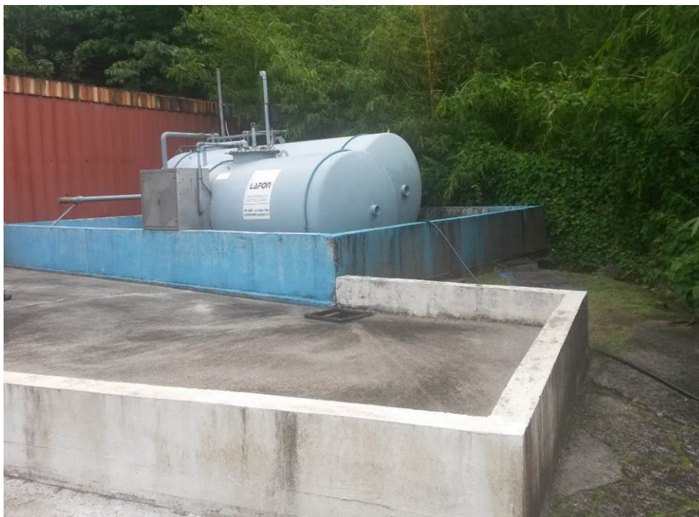
Figure 30 : Cuves de gasoil et zone de dépotage
