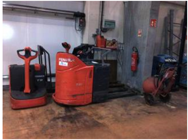
Zone de chargement des batteries des transpallettes électriques et autolaveuses
