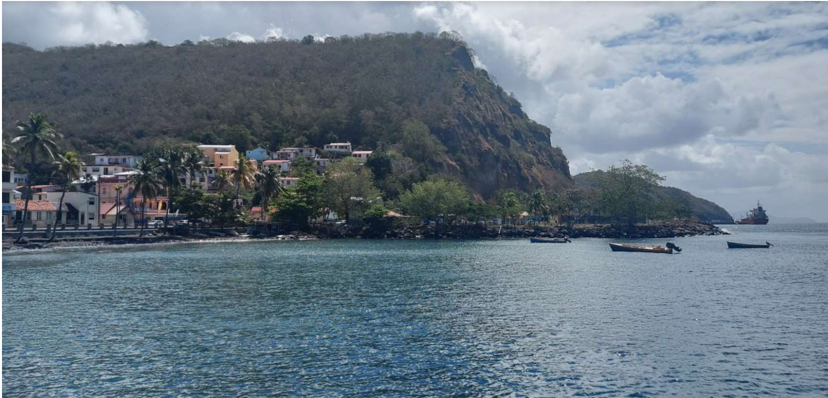
Photographie n°3 : Prise depuis le quai – Vue sur l'énrochement à remodeler – 25/02/2021
