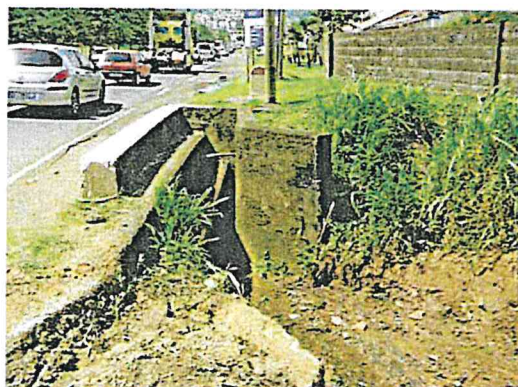
Photo 17 : Entonnement avant franchissement de la RN1
