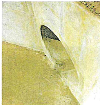
Photo 13 : Exutoire du chenal de décharge
