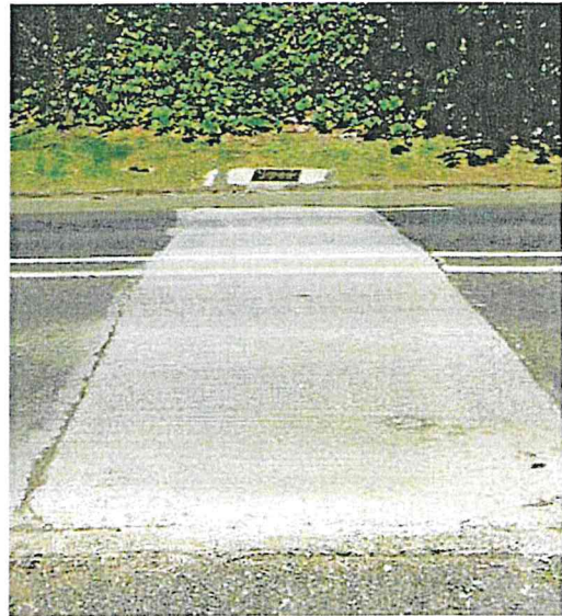
Photo 12 : franchissement de la RN1 (Ø1 200 mm) du chenal de décharge
