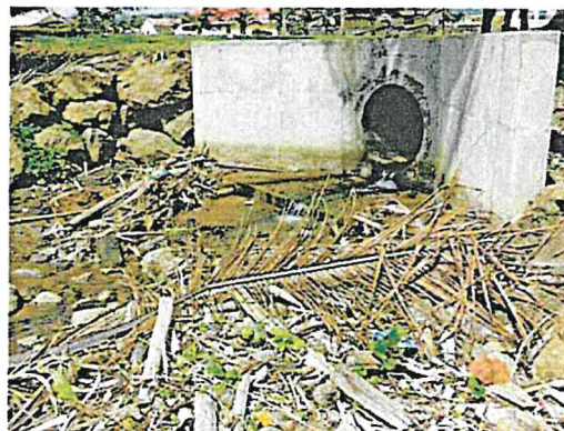
Photo 18 : Exutoire des écoulements principaux
