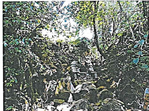
Photo 6 : Ravine très marquée en amont du stade : blocs rocheux et carcasses
