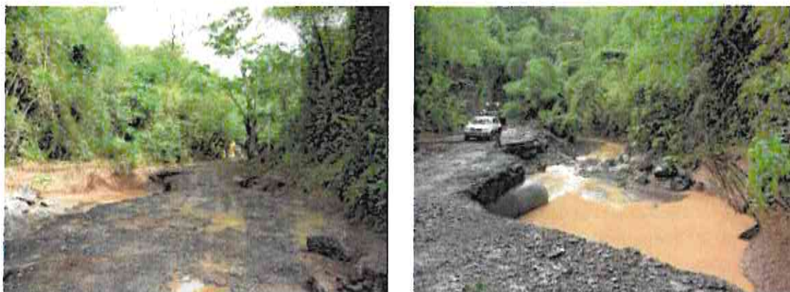
Figure 48. Exemple de l'état des routes et des berges avant travaux. 2009.
