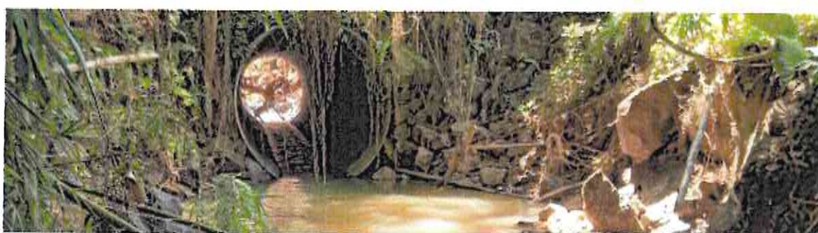
Figure 46. Photo de l'ouvrage 5 – Vue par l'aval. Novembre 2020.
