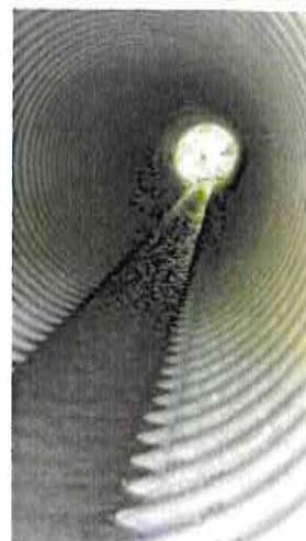
Figure 50. Photo de l'intérieur de l'ouvrage 4 en Mars 2018 à 14h00.
