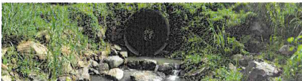
Figure 44. Photo des enrochements végétalisés en aval de l'ouvrage n°4 - Mars 2018.
