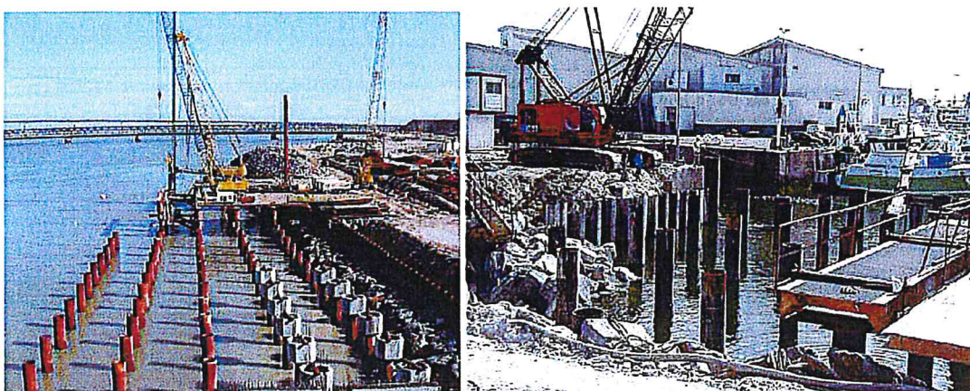
Figure 8 : Bataillage des pieux de fondation de quais béton depuis la berge
