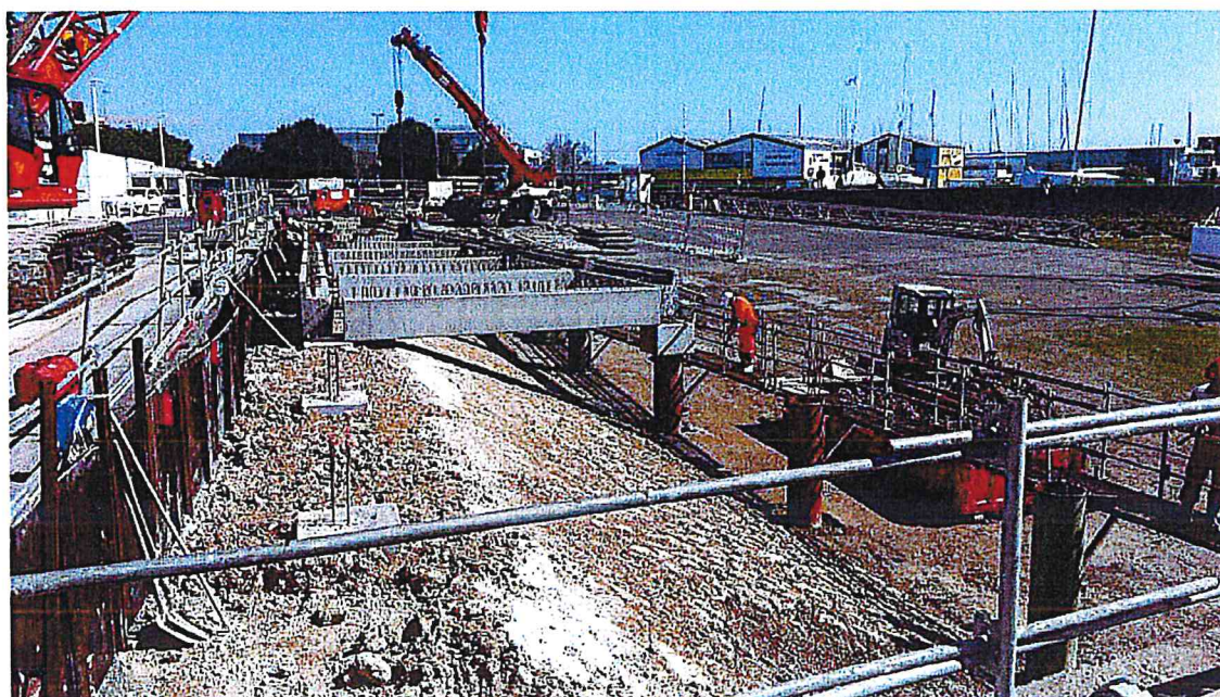
Figure 9 : Pose de poutres en béton armé préfabriquées sur pieux métalliques
