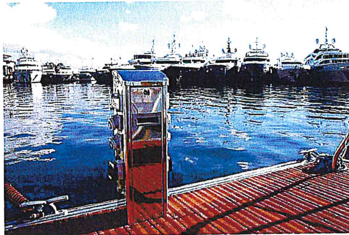
Figure 7 : Borne AEP/électricité avec balisage intégré
