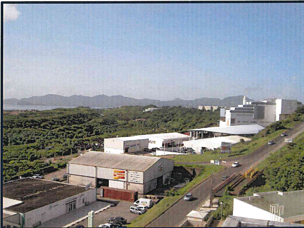
Figure 1 : terrain dans l'environnement proche - photographie n°1 (source : Suez Consulting/CACEM, 2013)
