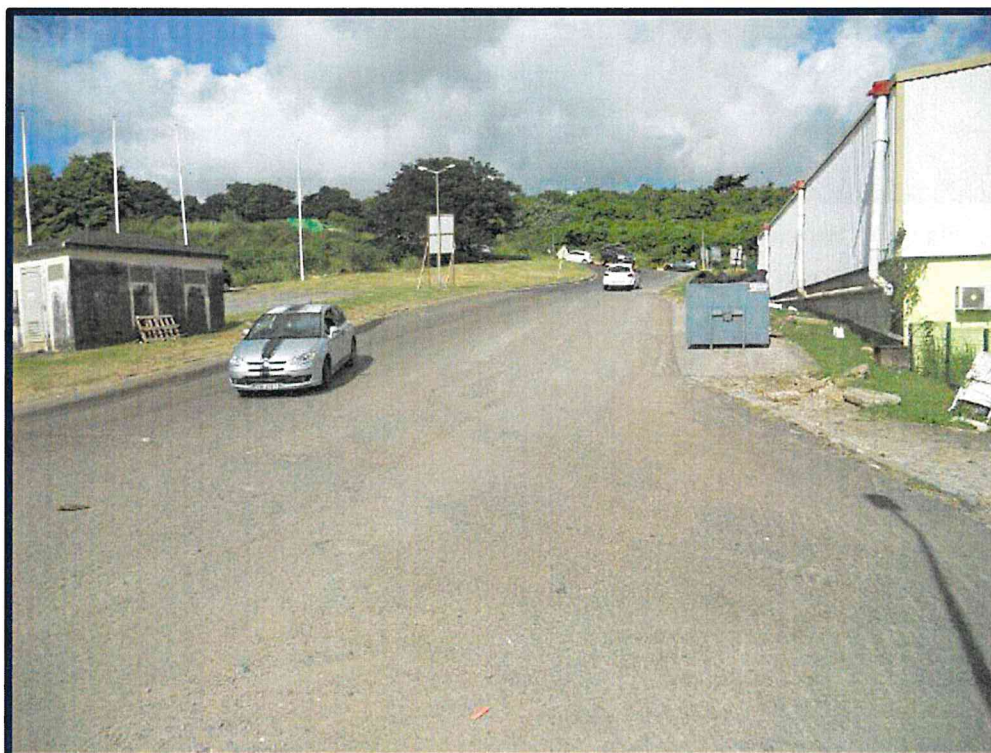
Figure 3 : terrain dans l'environnement proche - photographie n°3 (source : Suez Consulting/CACEM, 2013)
