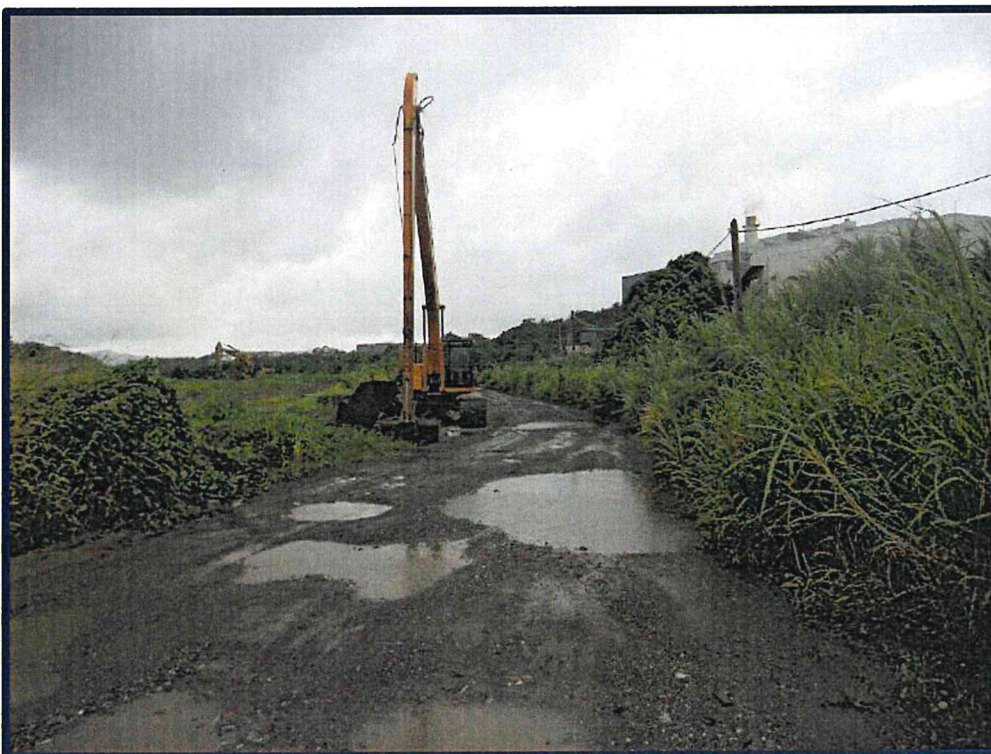
Figure 5 : terrain dans l'environnement proche - photographie n°5 (source : Suez Consulting/CACEM, 2013)
