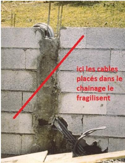
**Le passage de canalisation ou réseau dans le chaînage est interdit. Il obéit à des règles strictes pour les murs primaires (cf fiches 5 à 10).**
