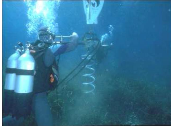
Figure 25 : Installation d'une ancre hélicoïdale par des plongeurs (Neptune environnement)
