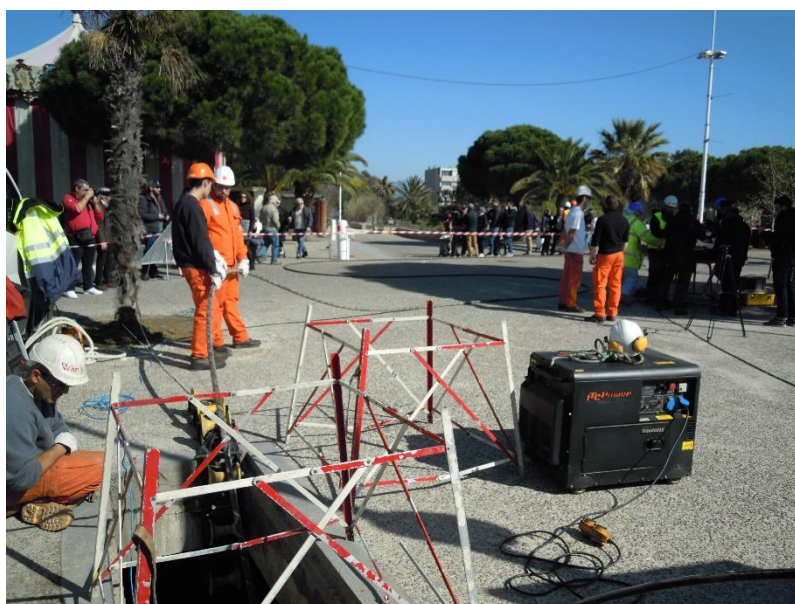
Figure 17 : Tirage du câble en dehors de la chambre plage avant raccordement
