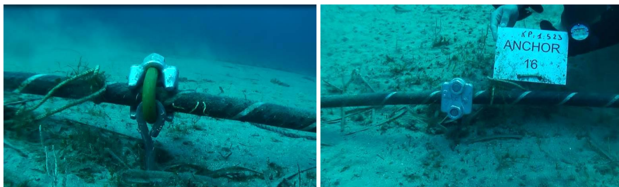
Figure 24 : Système de fixation du câble à l'ancre retenu pour le projet (Orange Marine)
