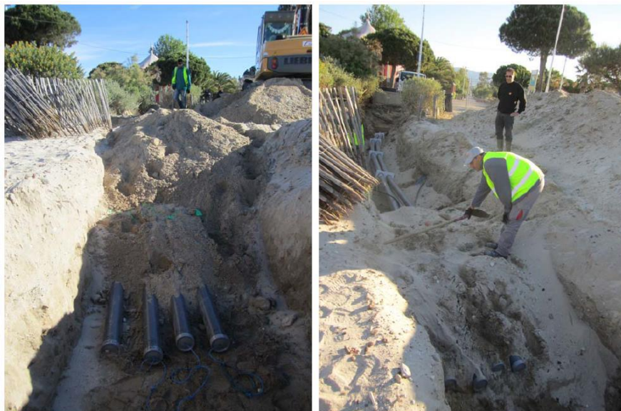
Figure 12 : Illustration de fourreaux d'accueil en haut de plage, dégagés à l'occasion des travaux préparatoires à la réception d'un câble en 2014 (Orange Marine)
