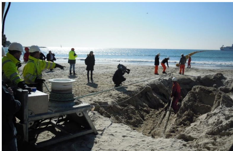
Figure 15 : Opération de tirage du câble avec un cabestan hydraulique
