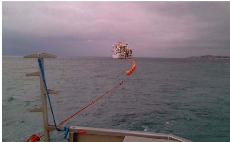
Figure 14 : Tirage du câble du navire câblé vers la plage (Orange Marine)
