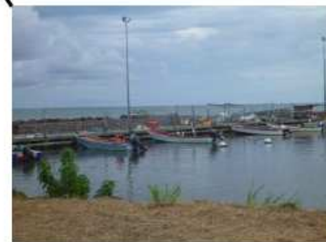
Appontement en bois de 100 ml le long de la digue en enrochements
