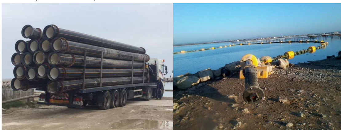
Figure 16 : Photographies de conduites de refoulement terrestre (à gauche) et flottante (à droite)
