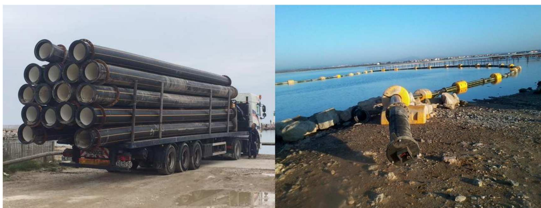
Figure 31 : photographies de conduites de refoulement terrestre (à gauche) et flottante (à droite)
