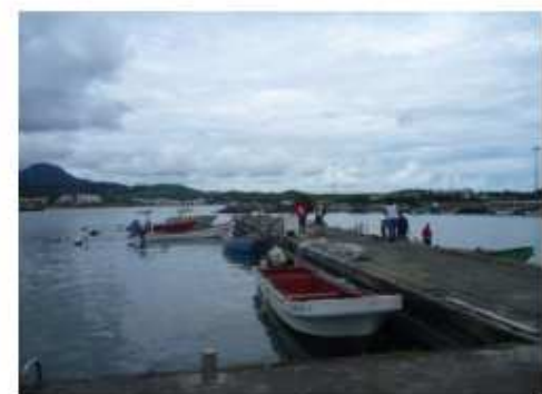
Appontement béton sur pieux (49 ml)
