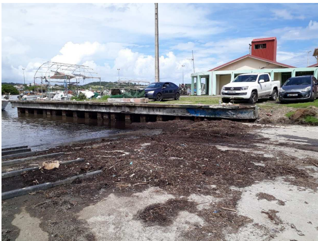
Figure 7 : Photo des dépôts organiques sur la cale de mise à l'eau (source : SAFEGE, 27/10/2017)
