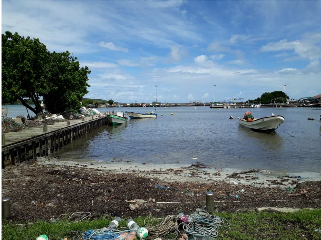
Figure 9 : Photo des dépôts organiques le long du quai sud ensablé (source : SAFEGE, 27/10/2017)
