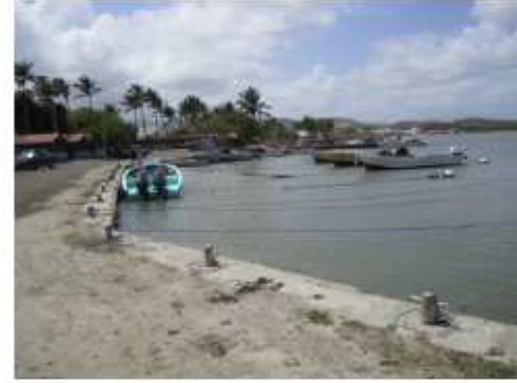
Quai de débarquement en béton (100 ml)
