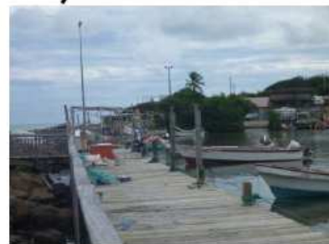
Appontement en bois de 100 ml le long de la digue en enrochements
