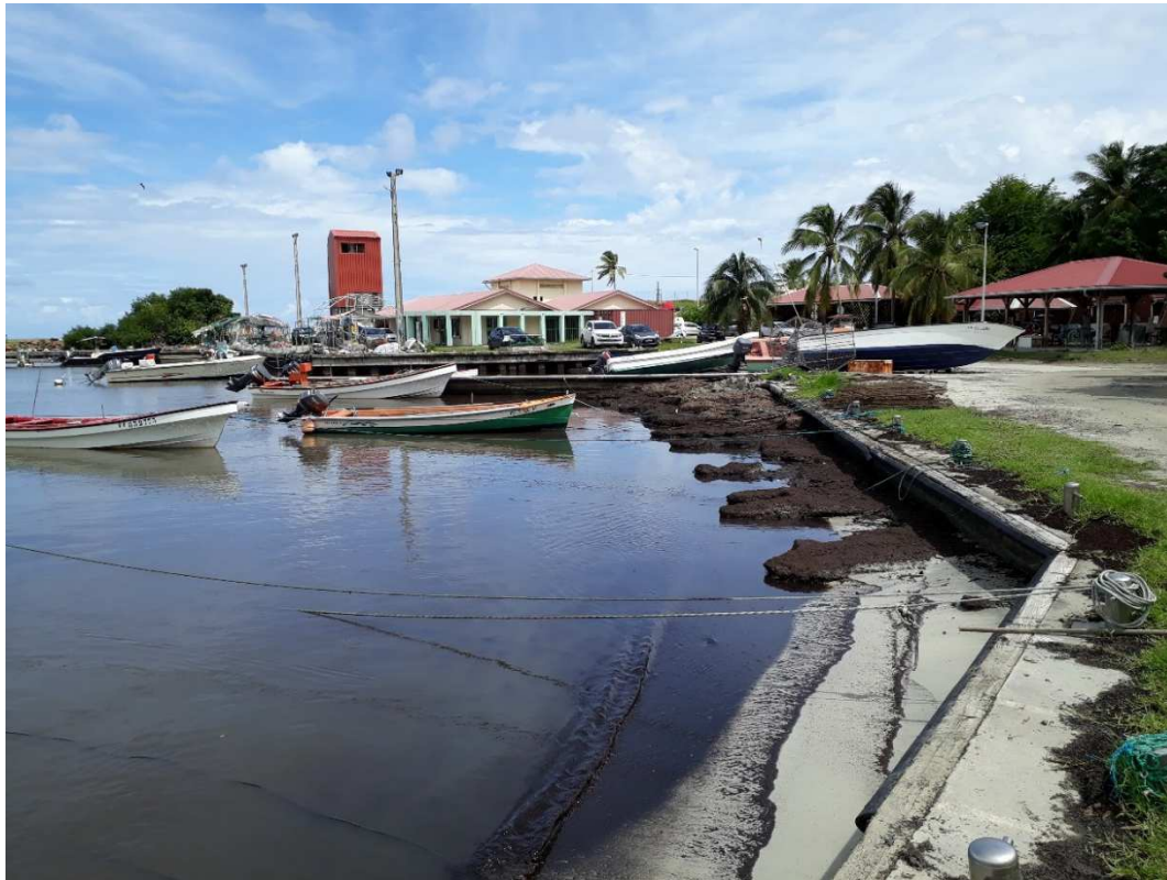
Figure 8 : Photo des dépôts organiques le long du quai sud ensablé (source : SAFEGE, 27/10/2017)
