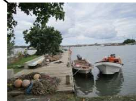
Quai en bois de 33 ml le long de l'épi d'enclôture
