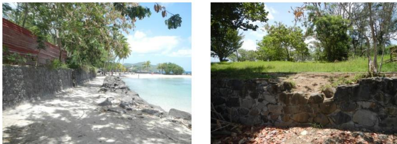
Muret de haut de plage - Source : BERIM-CREOCEAN
