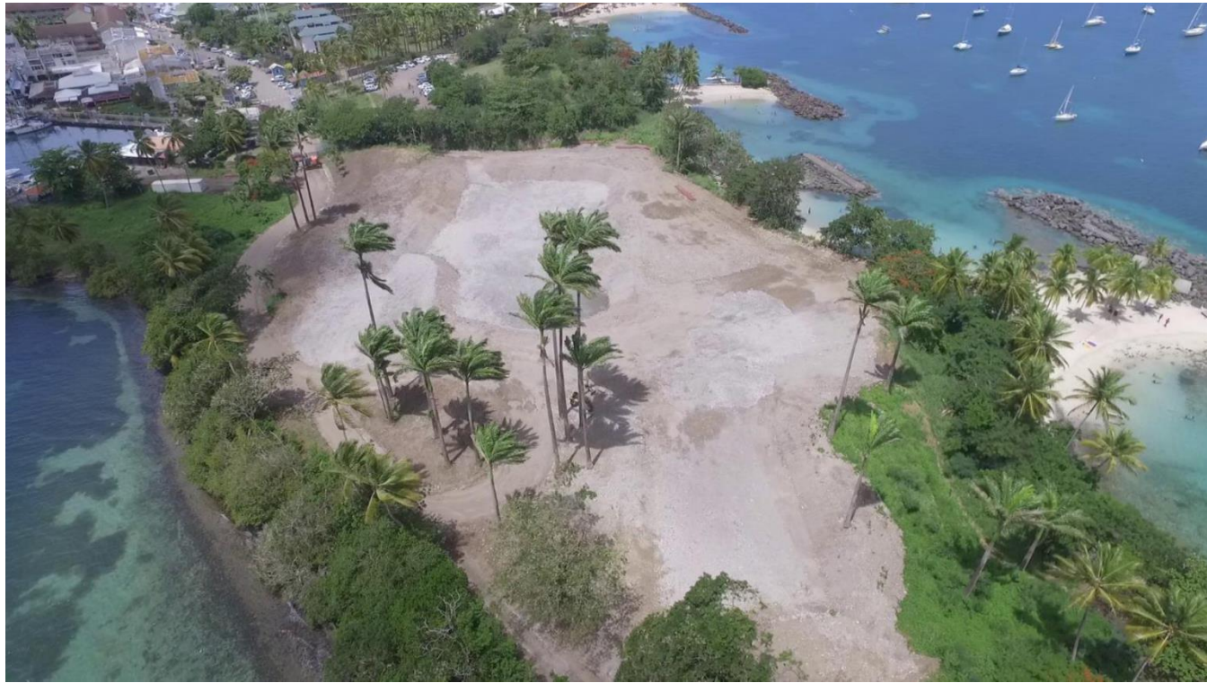
Photographie 10 : Photo aérienne du site après démolition de l'ancien hôtel en 2016. La frange littorale sera maintenue en l'état
