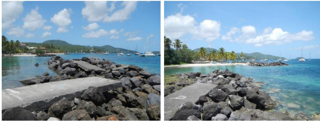
Figure 17 : Etat des brise-lames existants - Source : BERIM-CREOCEAN
