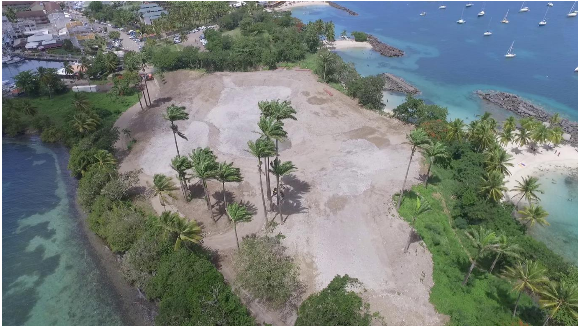
Figure 5 : Photo aérienne du site d'étude après démolition de l'ancien hôtel - Juillet 2016
