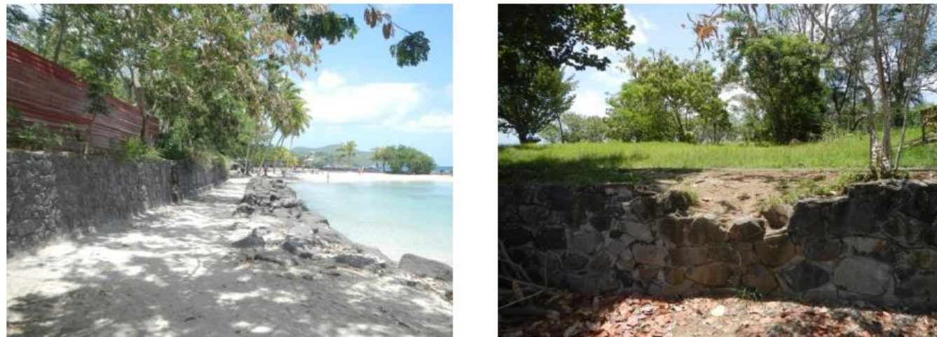
Figure 18 : Muret de haut de plage - Source : BERIM-CREOCEAN
