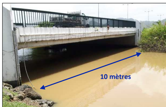
Figure 10 : Vue aval de l'ouvrage hydraulique (route D1) de la rivière Desroses (Safege - 01/08/16)
