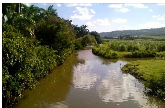
Figure 9 : Rivière Desroses recalibrée en amont de la route D1 (Safege - 22/08/16)
