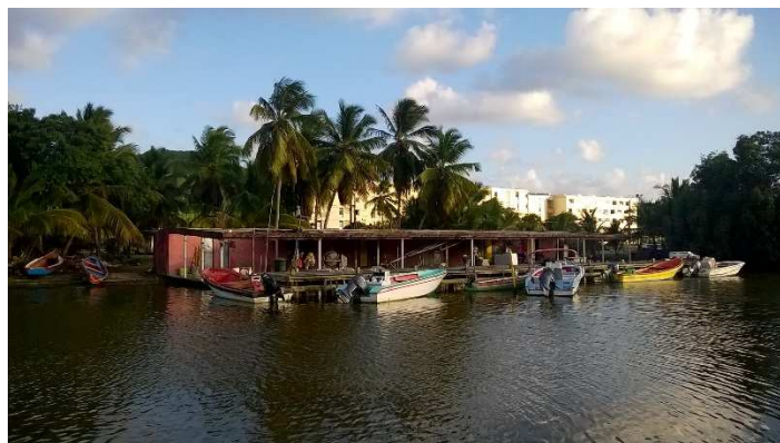
Figure 48 : APID La Jetée sur le Canal du François (Safege - 17/08/16)
