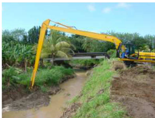
Figure 22 : Travaux de curage en rivière à l'aide d'une pelle à long bras (DIREN Martinique)
