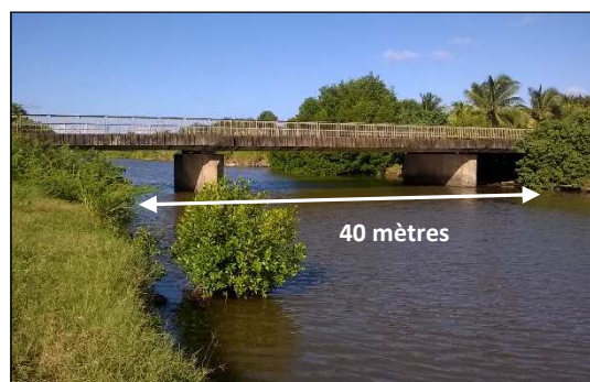
Figure 18 : Vue amont de l'ouvrage hydraulique du Canal du François (Safège - 22/08/16)
