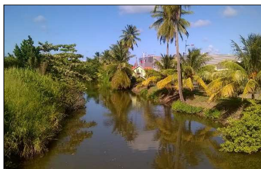
Figure 11 : Rivière Desroses recalibrée en aval de la route D1 (Safege - 22/08/16)
