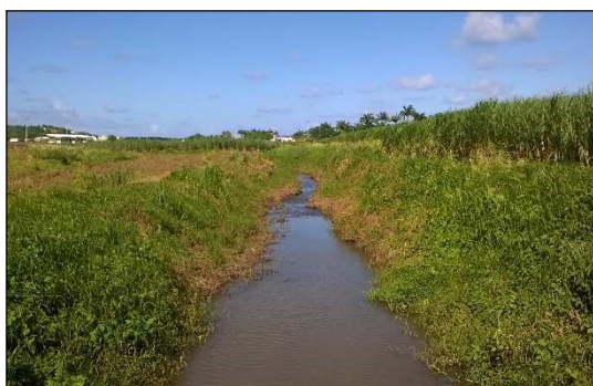
Figure 8 : Rivière Desroses rectifiée et recalibrée au sein des plantations de cannes à sucre (Safege - 22/08/16)
