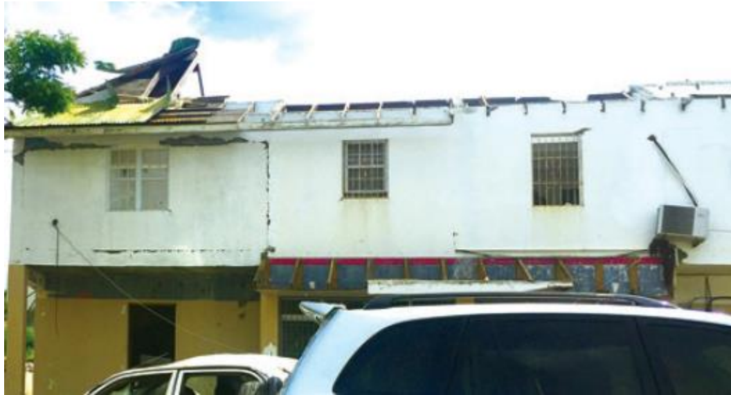
Structure dégradée au niveau du chaînage (Guide pratique – Maçonnerie)
