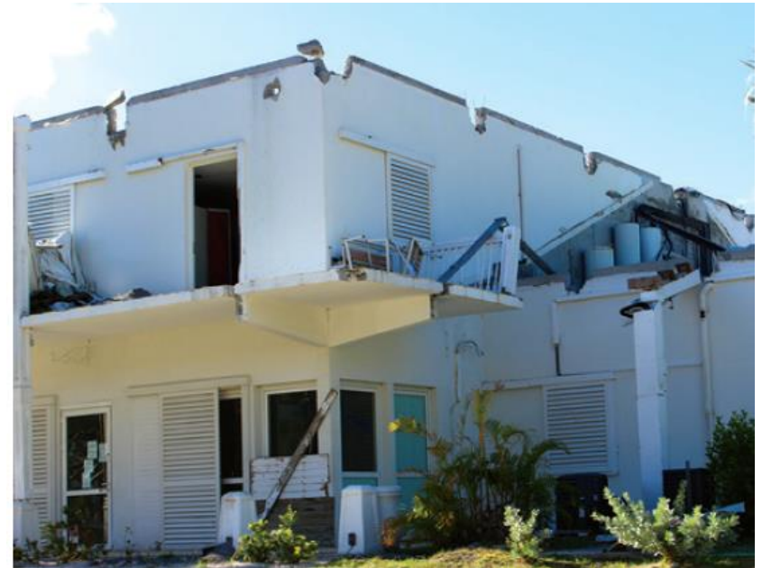
Rupture due à l'arrachement de la charpente (Guide pratique – Maçonnerie)
