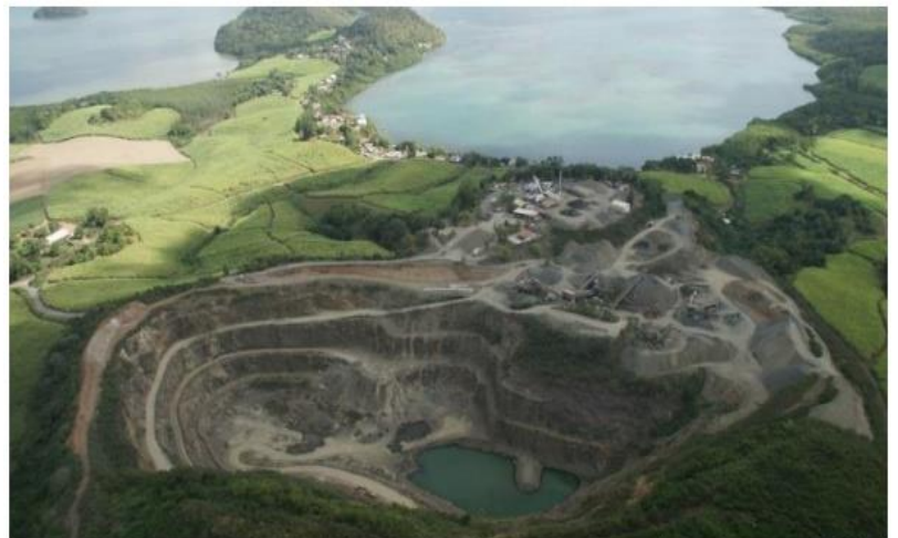
Le centre d'enfouissement de Petit Gallon est une ancienne carrière. (photo avant travaux). ©SMTVD
