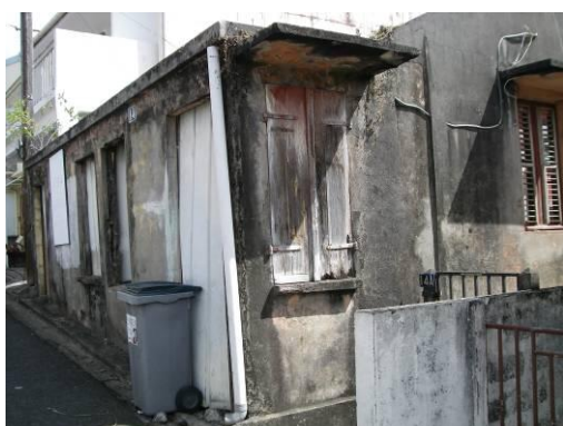
Le PIG : avant travaux
