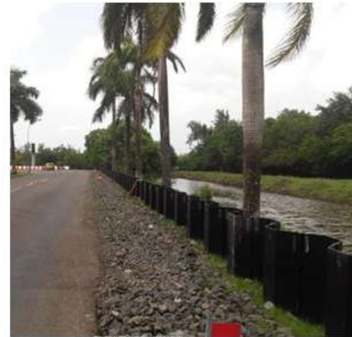
Digue le long de la route de l'aéroport
