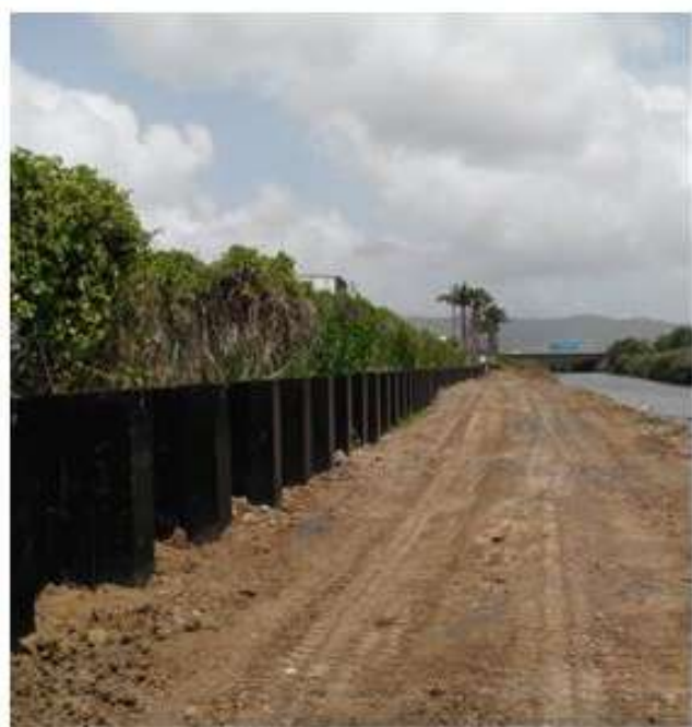
Digue le long de la ZI Lézarde après travaux
