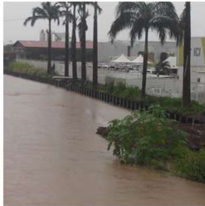
Fonctionnement des digues à la ZI Lézarde (Martinique Auto) lors des pluies du 08/11/14
