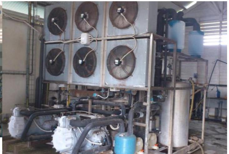
**Figure 11 : Aéroréfrigérants et compresseurs**
