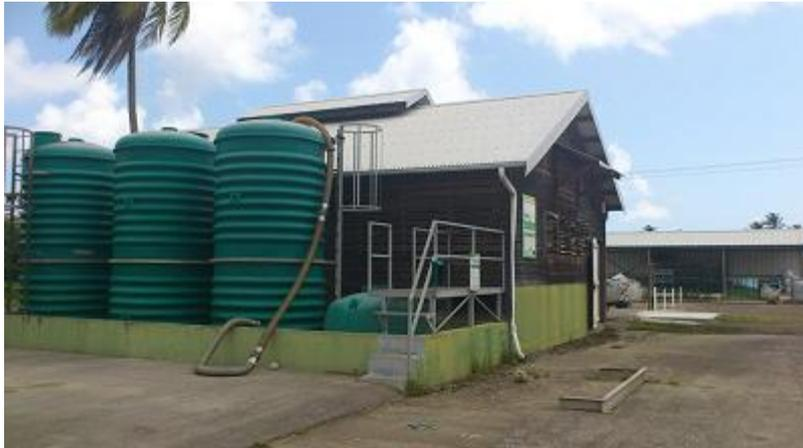
**Figure 6 : 4 des 6 cuves de stockage des bouillies fongiques (source : BURGEAP)**
