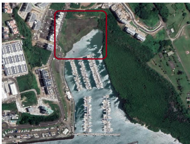
Localisation du projet au sein de la baie de l'Étang Z'Abricot
