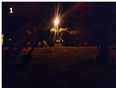
1. Vue sur un lampadaire éclairant la RN2
