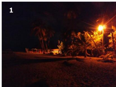
1. Vue sur les éclairages publics de l'allée des Amandiers
