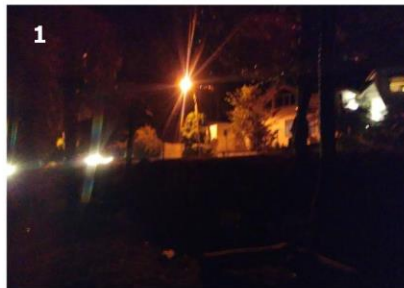
1. Vue sur les lampadaires de voirie de la RD7
