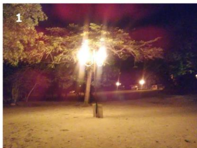
1. Vue sur les luminaires de la plage d'anse figuier
