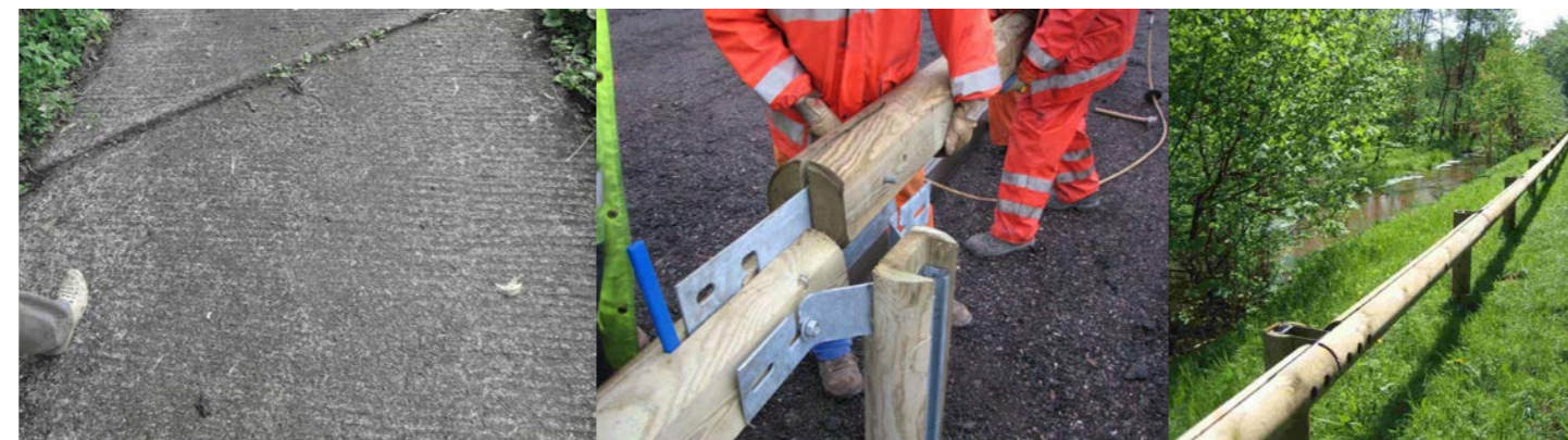
Réfection de la route béton, 150 € HT / ml
