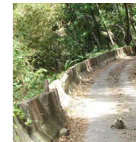
Les glissières à modifier
