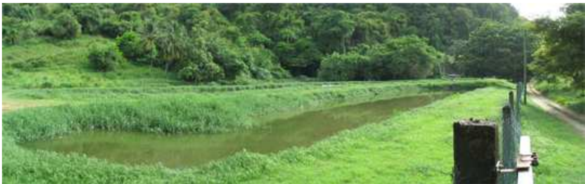
Bassin d'épuration du Carbet
