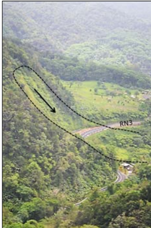
↑ Vue aérienne du glissement de la Médaille
